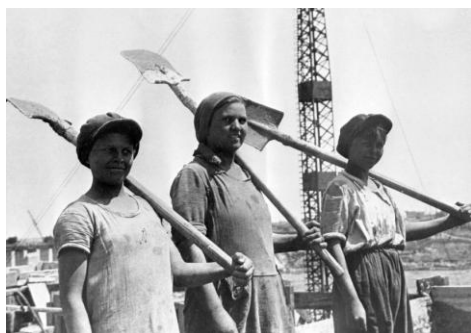
Группа комсомолок-бетонщиц на строительстве «Любовь, комсомол и весна»
